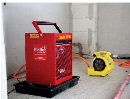
6 | Der Ventilator sollte in den Ecken eines Raumes stehen und die feuchte Luft zum Trocknungsgerät transportieren.
