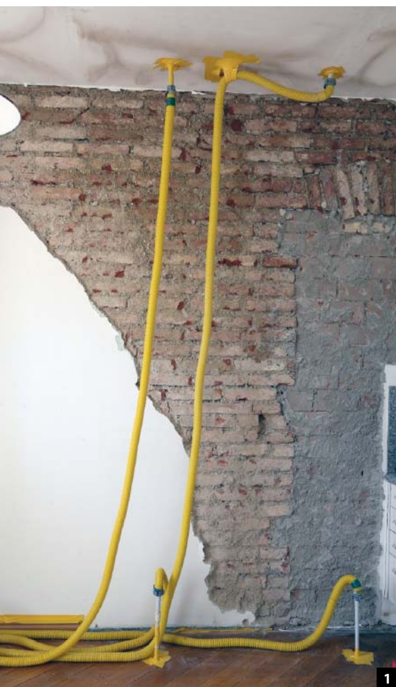
Abb. 1/2: Nach einem Rohrbruch im 5. Obergeschoss musste die Estrichdämmschicht getrocknet werden. Um den Oberbelag zu erhalten, wählte man den Aufbau vom 4. Obergeschoss durch die Holzbalkenkonstruktion. Auch die Fußbodenkonstruktion musste hier technisch getrocknet werden.
