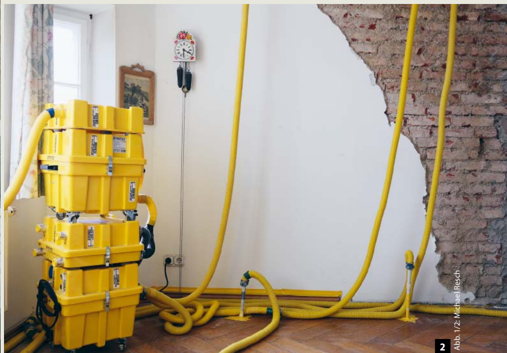
Abb. 1/2: Nach einem Rohrbruch im 5. Obergeschoss musste die Estrichdämmschicht getrocknet werden. Um den Oberbelag zu erhalten, wählte man den Aufbau vom 4. Obergeschoss durch die Holzbalkenkonstruktion. Auch die Fußbodenkonstruktion musste hier technisch getrocknet werden.
